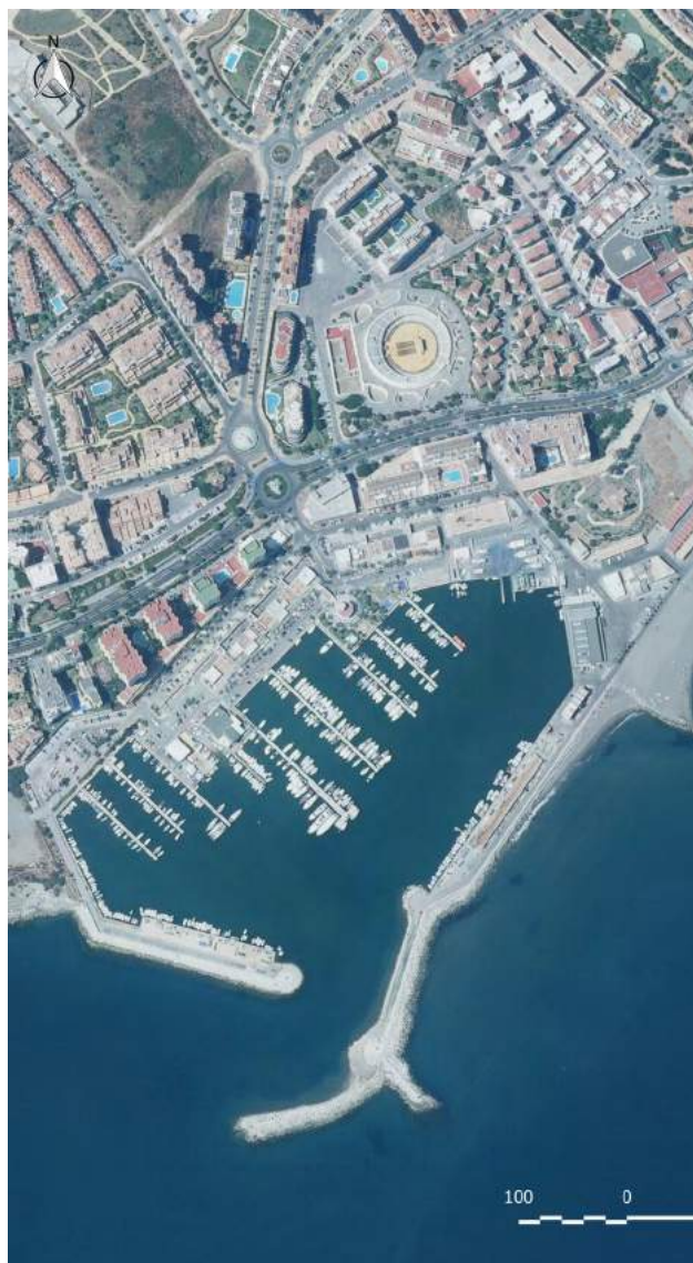
Imagen 5. Ortofoto del puerto de Estepona
